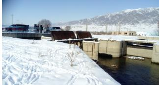
• Структура водораздела (первая структура в канале) так же следует рассмотреть ее замену на прибор электронного подъема., как шлюзы поднимаются кранами.
