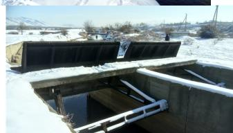
• Два водовода протекают, нуждается в ремонте. Способ ремонта был обсужден, вариант использования наиболее устойчивых материалов вместо бетона будет рассматриваться (см. рис. выше).
