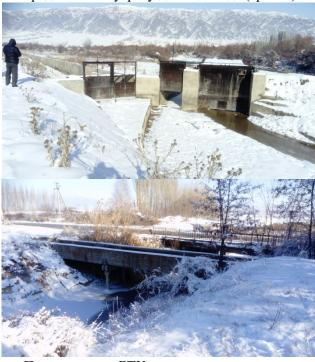
• Протекание из БТК в часть, состоящую из гравия, вызвала заболачивание в нижней части канала. На посещенных местах дренажный канал идет под БТК. Улучшение дренажной системы предлагается в качестве решения.
